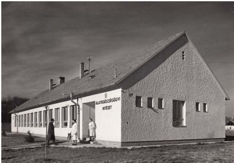
A Kaposvári Állategészségügyi Intézet induláskori főépülete (1951)
