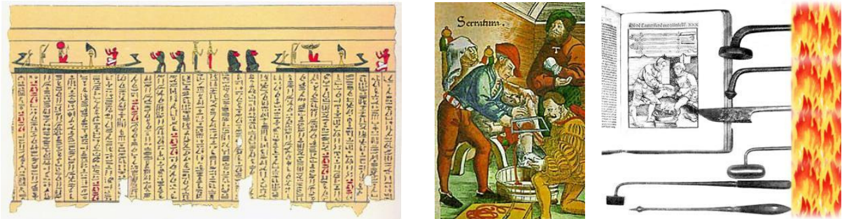
1. ábra. A felforrósított eszközzel történő vérzéscsillapítás több ezer éves múlttal rendelkezik. Balra a közel 5000 éves Imhotep papirusz részlete, mellette középkori végtagamputációról készült képek láthatók ( www.valleylab.com , 2011).
