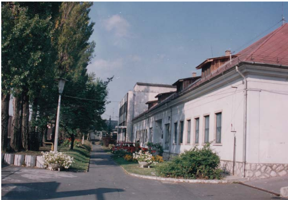
Az Intézet eredeti egyszintes épülete felújítás után és az 1969–1970-ben hozzátoldott háromszintes új laboratóriumi épület
