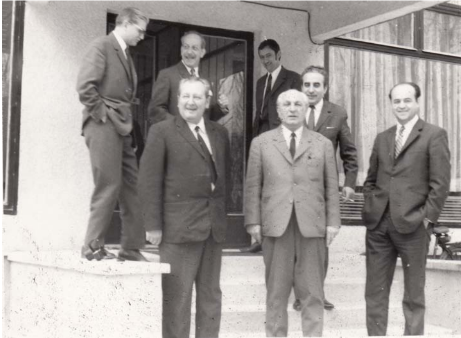
A Kaposvári Állategészségügyi Intézet bővítése után a bejárat előtt (1973)
