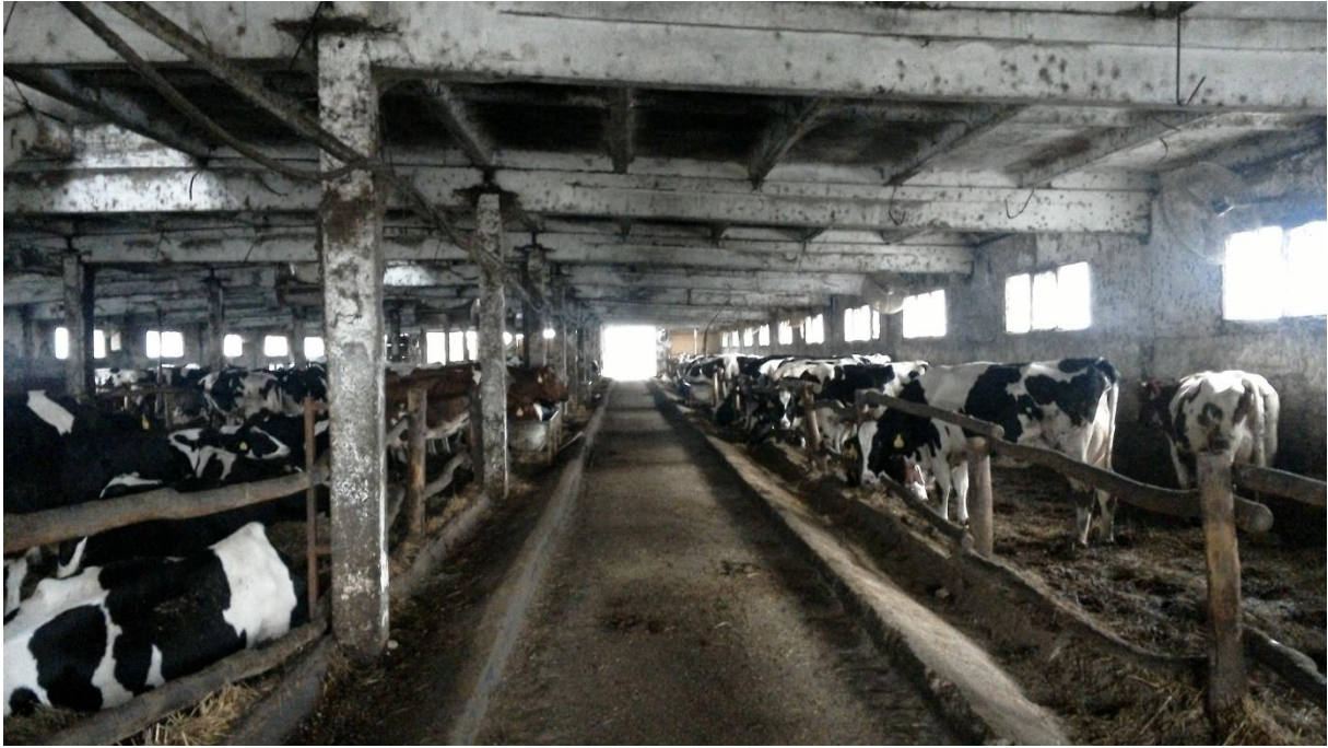
6.kép: Az alacsony istállomagasság mellett az oldalsó ablakok zártsága(üvegezett) és a folyosó végén lévő nyitott ajtó látható.
