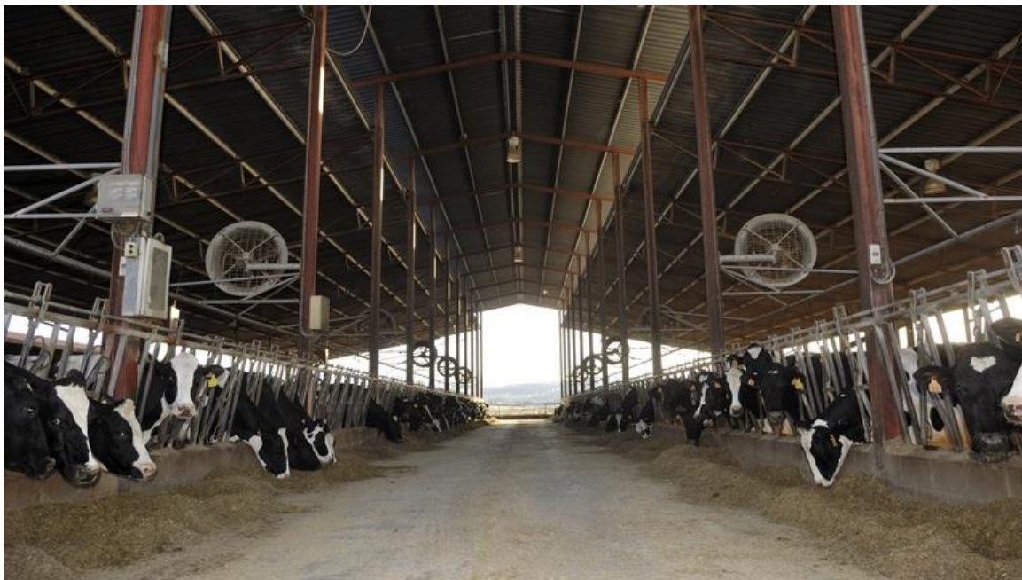
1.kép: A képen az istálló nagy belmagassága és a ventilátorok láthatók. [22]
