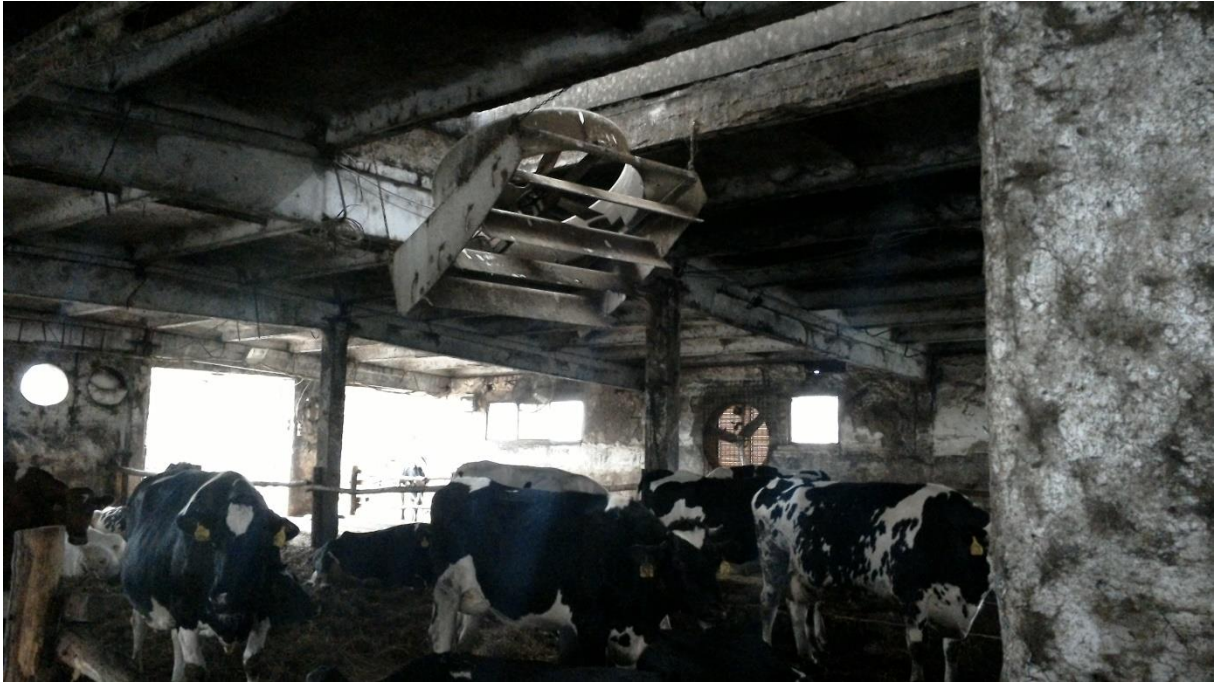
8.kép: A tetőn található nyílás és az alá felszerelt ventilátor látható a képen.
