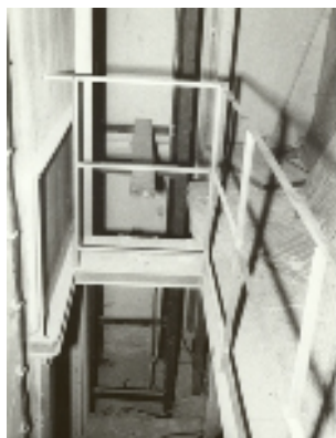
A raktári könyvlift építése.
